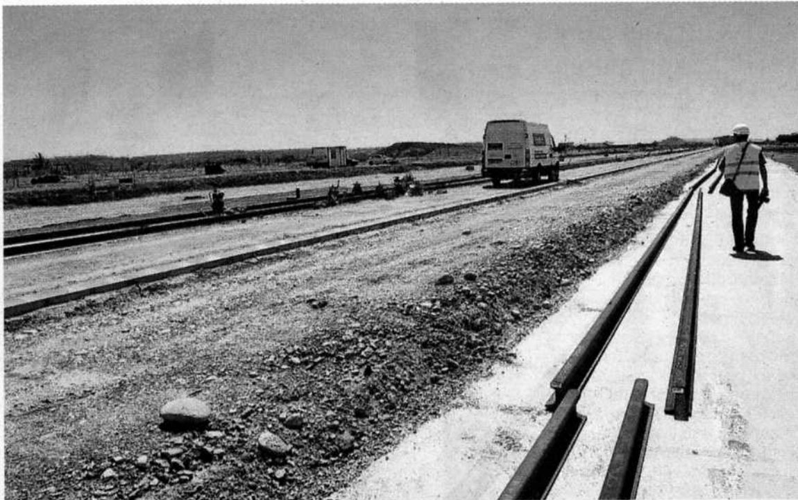
Vista general de las vías que componen el apeadero de La Armentera, todavía en obras. JOSÉ LUIS PANO
